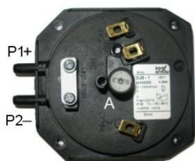
Dok je kotao isključen proverite pritisak na kojem dolazi do menjanja kontakta senzora diferencijalnog pritiska (presostat). Senzor diferencijalnog pritiska je fabrički podešen. Ispravan senzor treba da dovede do razdvajanja kontakata na povratnom pritisku koji je naznačen na oznaci senzora (videti tabelu). Senzor koji je podešen na ovaj način obezbeđuje ispravne parametre za ispuštanje dimnog gasa.
